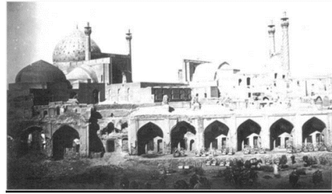
تصویر شماره (۱۳): نمای قدیم کاروانسرا
