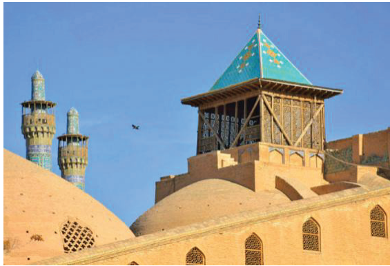
شکل شماره (۲): مأذنه مسجد شاه (منبع: آرمان، ۲ آگوست ۲۰۱۰)
