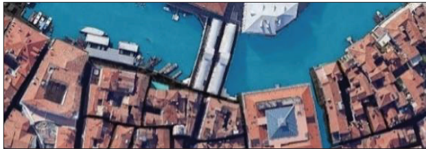
تصویر شماره (۱): ارتباط معابر توسط پل ونیز (Google Earth)
