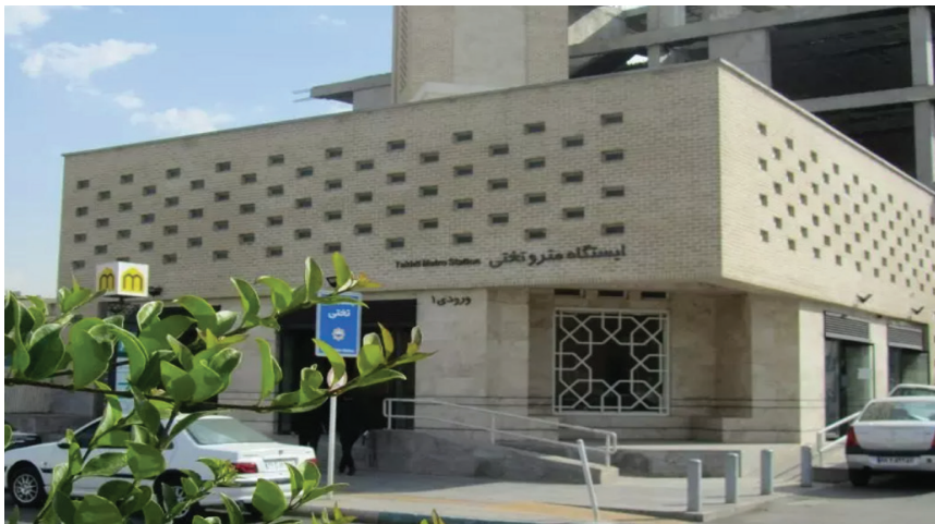
تصویر شماره (۱): ایستگاه متروی تختی
